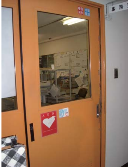
上：事務室内に設置されたAED 下：事務室入口のAED設置を示すステッカー
